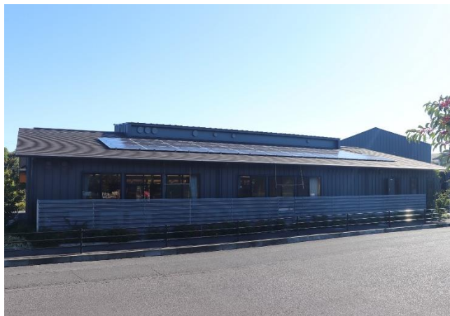
実証事業第 1 号建物 指定避難所でもある北小校区共生ステーション
