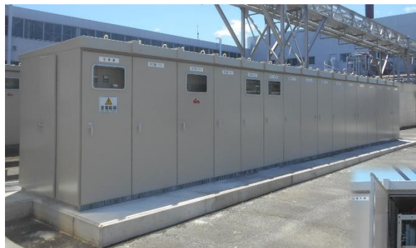
車載用バッテリーパックを搭載した 産業用太陽光自家消費蓄電池システム 「サファ Link-ONE」（日東工業製）
