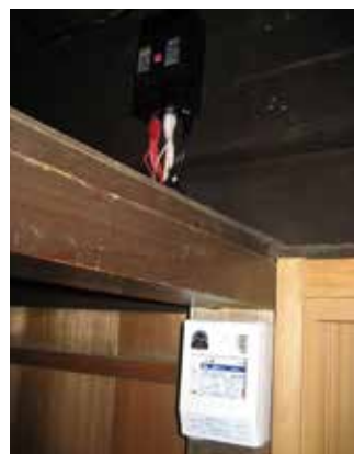
感震ブレーカー(既設用)設置事例
