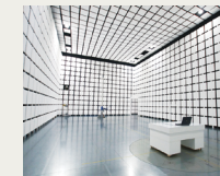
10m法電波暗室
