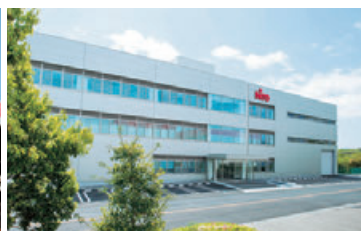
■菊川ラボラトリ(風雨・耐震試験棟)
