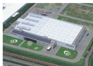
● 掛川工場 静岡県掛川市 [敷地] 68,000㎡ [建物] 16,000㎡ [主要製品] 小型キャビネット
