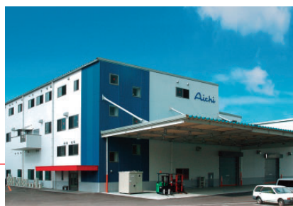
● 株式会社新愛知電機製作所 愛知県小牧市 [事業内容] 電気用諸機械器具の設計、製造、販売、修理等
