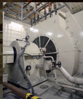
●短絡試験用発電設備
