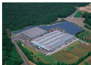
● 唐津工場 佐賀県唐津市 [敷地] 99,000㎡ [建物] 16,000㎡ [主要製品] 高圧受電設備、分電盤
