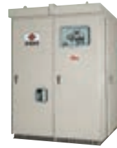
高圧受電設備
