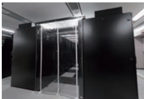
AISLE CAPPINGにより、コールドアイル部分を塞ぎ、エネルギー効率化を図っている
