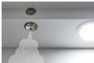
内装（天井、壁、扉）は不燃仕様で、天井に下方放出型消火装置（熱感知式）を装備しており、消防法に準拠しています。
