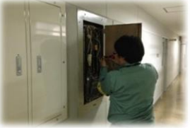
通信設備工事
