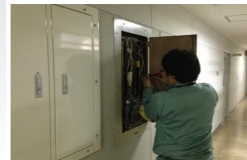
通信設備工事
