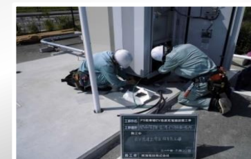
電気設備工事
