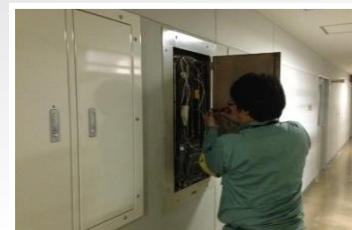
通信設備工事
