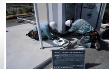
電気設備工事
