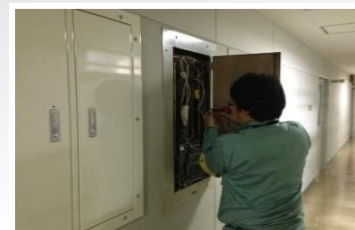
通信設備工事
