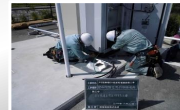
電気設備工事
