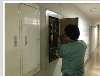
通信設備工事
