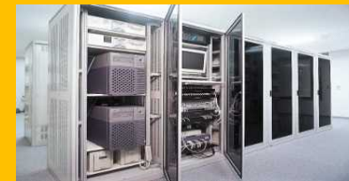
システムラック
