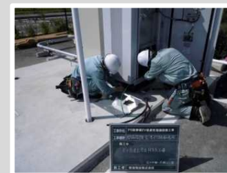
電気設備工事
