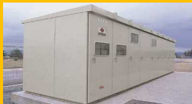
高圧受電設備
