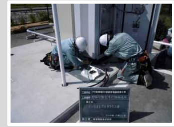
電気設備工事
