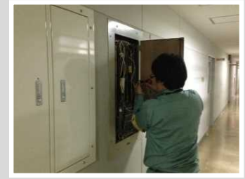
通信設備工事
