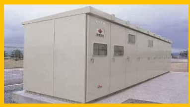
高圧受電設備
