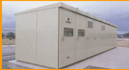
高圧受電設備
