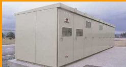
高圧受電設備
