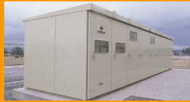
高圧受電設備
