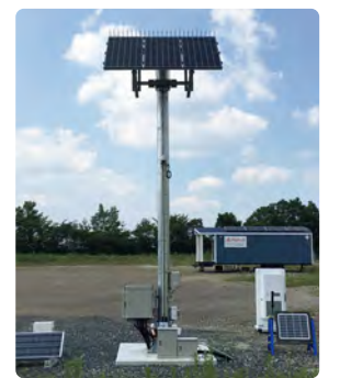
▶ 知の拠点あいち 新エネルギー実証研究エリア
