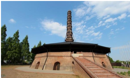
旧下野煉化製造会社煉瓦窯（通称、野木町煉瓦窯）
